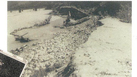
立谷沢川右岸堤防欠壊 (昭和31.7.17)
