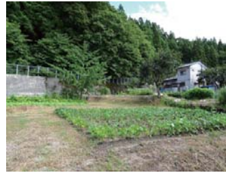
擁壁工 (木の沢地区) 崩れてくる土砂を受け止める。
