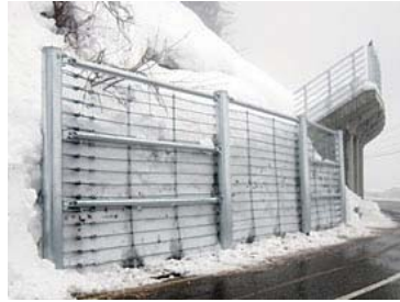
(左) なだれ予防柵 斜面の上のほうにつくり、なだれの発生をおさえる。
