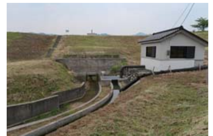
最上川に流れ込む小川につくられた水門(上)と排水機場(下)
