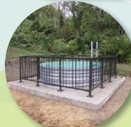
しゅうすいせい ▲集水井
