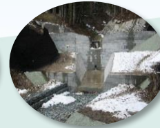
さほうえんてい ▲砂防堰堤
