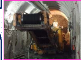
←この機械で地下水を排除するためのトンネルを掘っていきます。(奥が掘削面です。)
