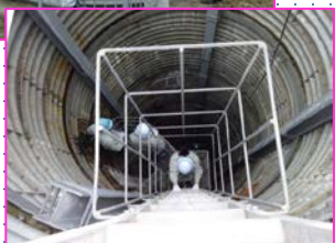
→実際に集水井の中に入り点検の実技を学びました。 深さは15mもあります。
