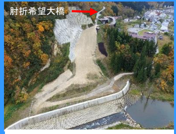
平成28年に完成した肘折山腹工(さんぶくこう)
