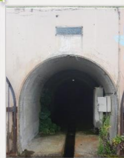
豊牧排水トンネル
