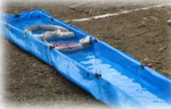
→側溝の回収時
