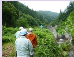
二の沢砂防堰堤施設点検(真室川町)
