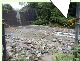
▲大井沢第二砂防堰堤
