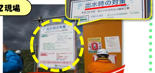
最上川中流丹生川護岸工事 /工事現場
