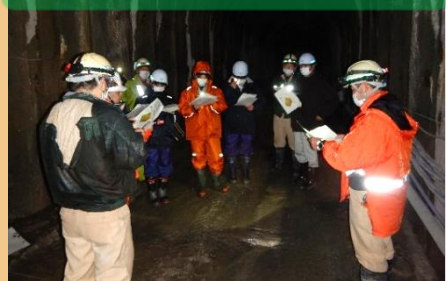
志津地すべり排水トンネル第1期工事 (トンネル内部真っ暗・・・大丈夫見えています!)
