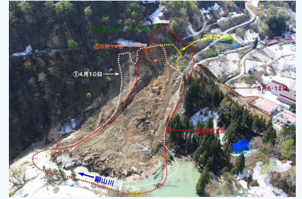
写真：H24年肘折地区で発生した地すべり性の斜面崩壊 銅山川が一時、土砂でせき止められ、肘折温泉が浸水するおそれもありました。
