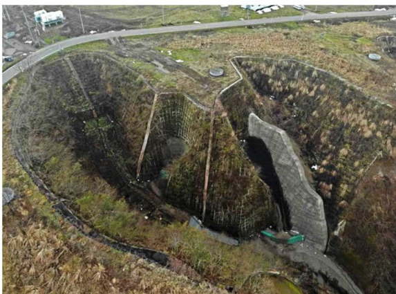
銅山川流域大曲沢山腹工補修ほか工事
