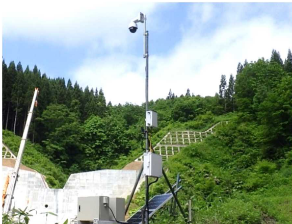
角川流域興屋沢砂防堰堤群工事
