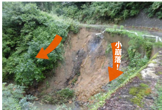
↑赤砂川 赤砂第8砂防堰堤管理用道路
