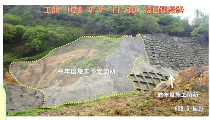
本工事は、平成24年に崩落した法面を、法枠工とアンカー・鉄筋挿入工で補強して、更なる崩落を防止するものです。
