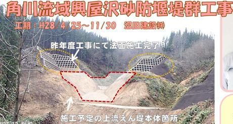
本工事は、興屋沢において土砂流出を防ぐための砂防 えん堤を二基設置するものです。昨年度はえん堤上部の 法面を施工しました。今年度は上流のえん堤本体の施工 と、下流のえん堤への工事用道路を施工する予定です。
