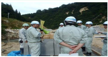
▲肘折護岸工事現場にて
