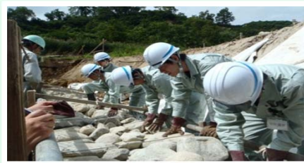
▲豊牧の工事現場にて石積み作業体験
