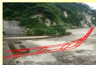
▲カゴマット 護岸工の 断面図
