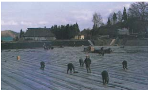
▲沼底にアスファルトシートを張る (沼底の泥を除去し基盤を造りながらの施工は、厳冬期ということもあり非常に苦労されたそうです。)
