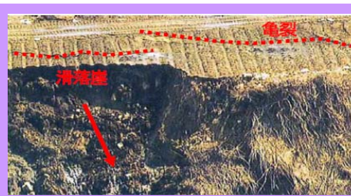
▲昭和54年春の被災 平林山ブロックの末端域で地すべりが発生し、地すべり頭部では滑落崖、引張り亀裂が発生し畑地が被災した。
