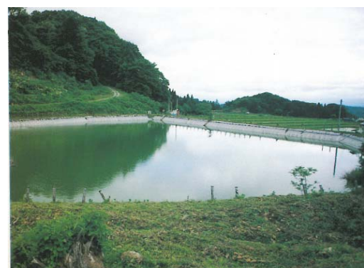
▲沼底にアスファルトシートを張る (沼底の泥を除去し基盤を造りながらの施工は、厳冬期ということもあり非常に苦労されたそうです。)
