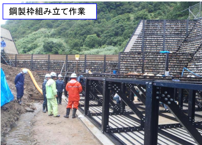
▲▼ 砂防堰堤の鋼製枠組み立て作業 (横道沢第五砂防堰堤改築工事現場)
