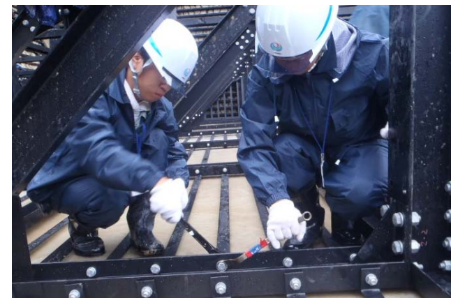
▲▼ 砂防堰堤の鋼製枠組み立て作業 (横道沢第五砂防堰堤改築工事現場)
