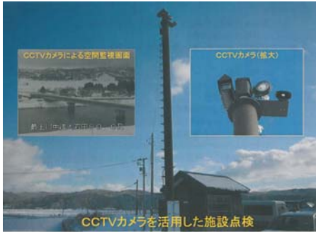
CCTVカメラを活用した施設点検
