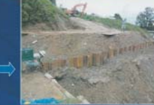
ウォータージェット併用油圧パイロハンマ工法
