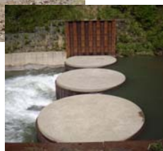
▲▶ 西大鳥川第二砂防堰堤（セルダム）
