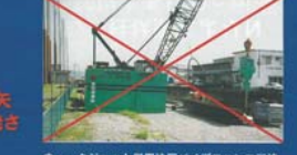
ウォータージェット併用油圧パイロハンマ工法
