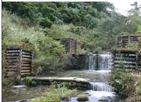
▲横道沢第二砂防えん堤
