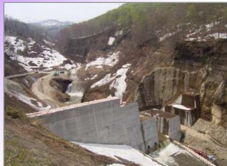
赤砂川上流部の大規模地すべり性崩壊地（昭和51年発生）の脚部保護及び流出土砂の調整（下流部の土石流の危険度を低下させる）を目的とした砂防堰堤の建設工事を継続します。主堰堤のほか、副堰堤の工事も進んでいます。今年度中に堰堤を完成させる予定です。
