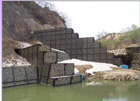
横道沢において既存の砂防堰堤を改築し、完成後に堆積する土砂による横道沢地区の地すべり活動抑止効果や、流出土砂の調整効果をさらに高める工事を今年度も施工していきます。
