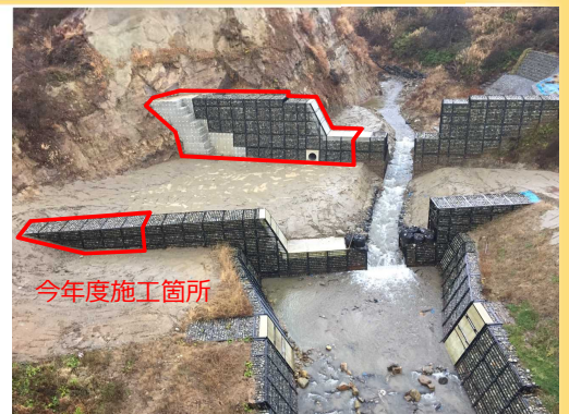
横道赤砂第1砂防堰堤 今年度工事完了時
