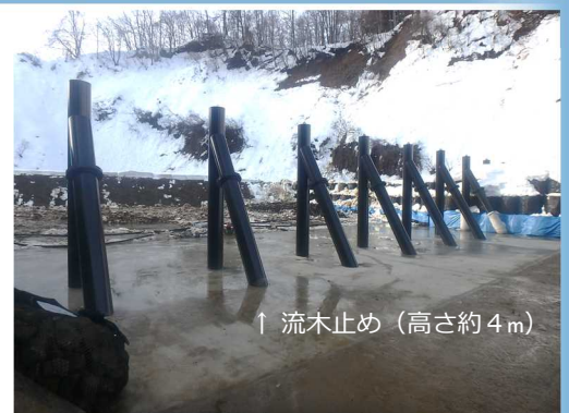
豊牧地区 流木補足工 完了時
