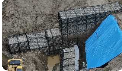
鋼製枠が組みあがる様子
