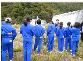
六瀬砂防堰堤
