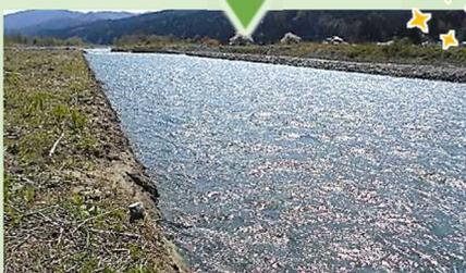
土砂が堆積し、川の流れる断面積が小さくなっていた箇所の河道を掘削
