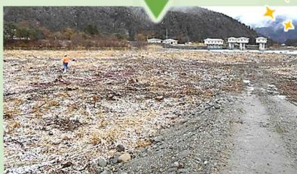
樹木が繁茂し、川の流れる断面積が小さくなっていた箇所の樹木を伐採
