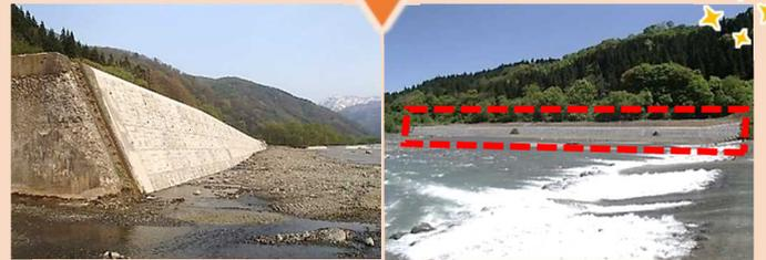
横クラック(ひび割れ)が入っていた護岸を取り壊して復旧
