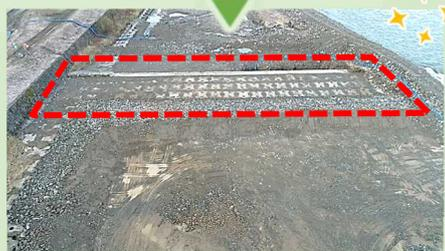
河床低下を防ぐ帯工と、帯工足元を保護する根固めブロックの損傷を復旧
