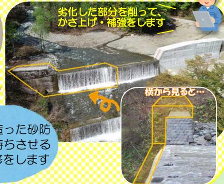
劣化した部分を削って、かさ上げ・補強をします
