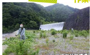
六淵砂防堰堤
