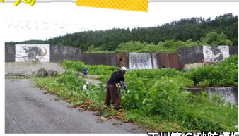
玉川第6砂防堰堤
