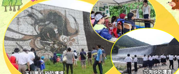
玉川第6砂防堰堤
