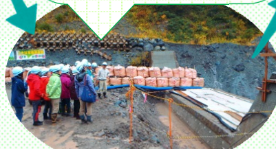
濁沢整備工事現場
