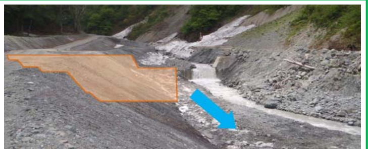
② 最上川水系立谷沢川流域 濁沢ほか整備工事 工期：H27. 3. 13～H27. 10. 2 施工業者：株式会社 柿崎工務所
