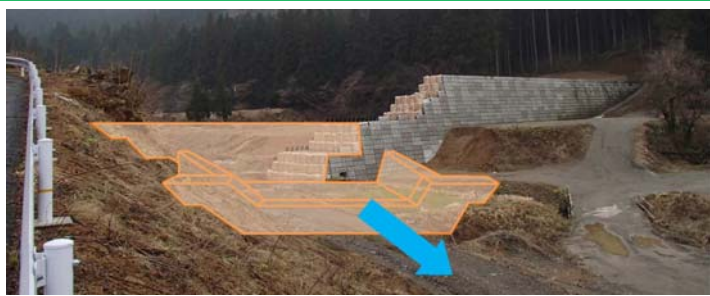
① 最上川水系立谷沢川流域 東大沢砂防堰堤工事 工期：H27. 2. 27～H27. 11. 30 施工業者：佐藤建設 株式会社
