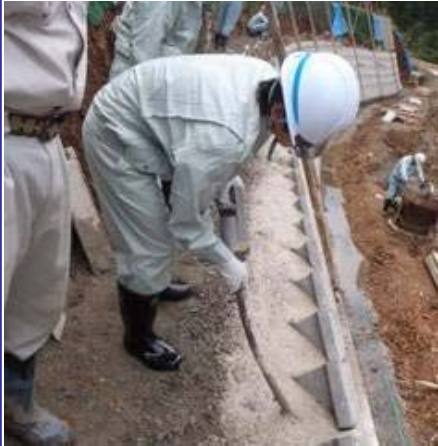
↑コンクリートをバイブレーターの振動で均一になるように締固めています。
