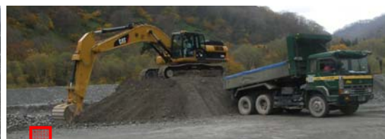
土砂をダンプに積み込んで運搬
