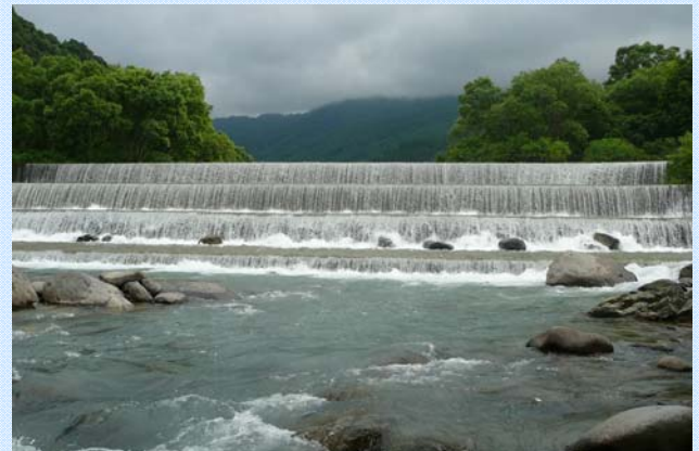
▲瀬場砂防堰堤(昭和28年12月完成) 高さ6m、長さ193.3m、貯砂量258,500m 3
