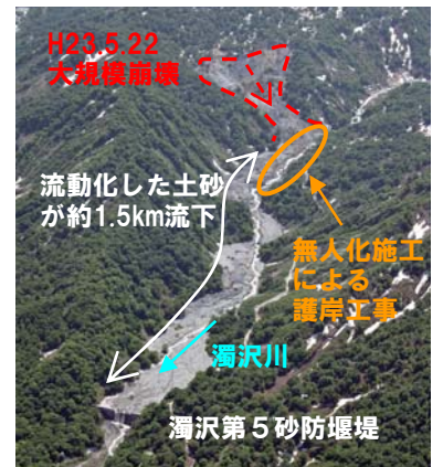
【濁沢川池ノ台地すべり箇所】
