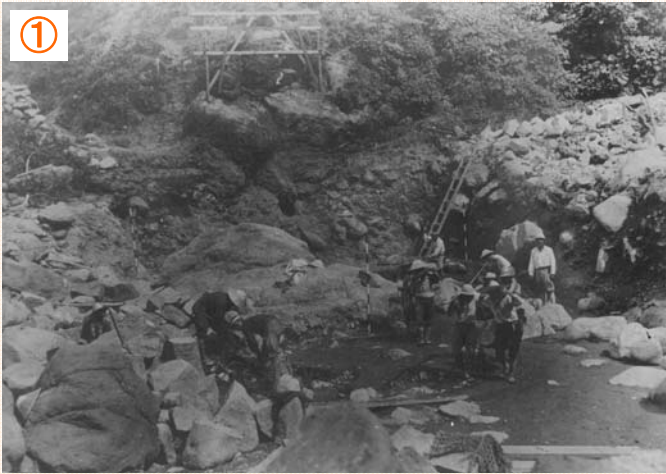
▲昭和13年 濁沢第1砂防堰堤掘削 バックホウなどの重機がなかった時代 すべてが人力での作業
