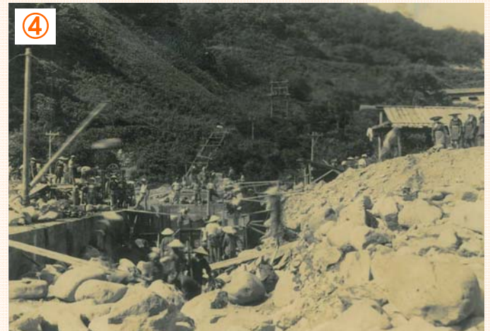
▲昭和24～27年 六瀬砂防堰堤の施工状況 デッキクレーンを使つての作業
