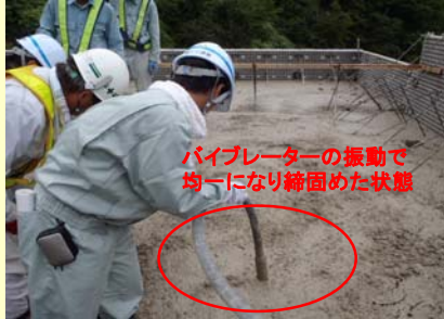
↑ コンクリート締固め実習 【本沢第二砂防堰堤改築工事】
