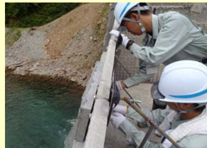
↑ コンクリート締固め実習 【本沢第二砂防堰堤改築工事】
