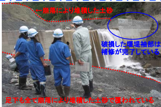
▲崩落斜面下流の濁沢第4砂防堰堤
