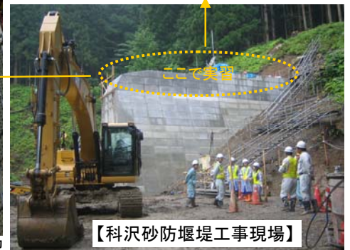
▲コンクリート打設時の出来高寸法確認
