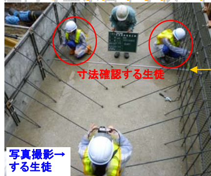
▲コンクリート打設時の出来高寸法確認
