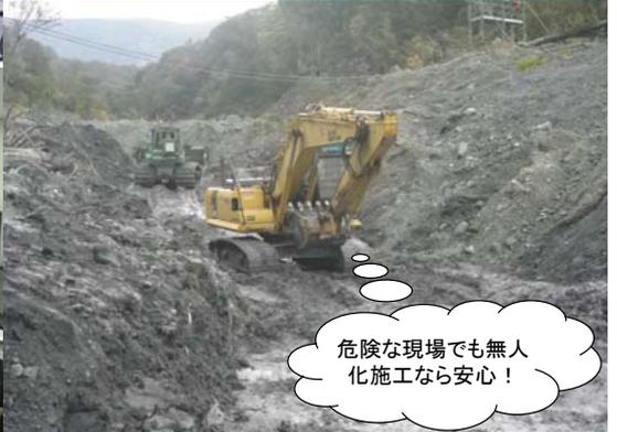
濁沢川の河床に異常堆積した崩壊土砂の出水時などにおける急激な土砂流出を防ぐため、早急に流路を固定し、侵食を防止するためにコンクリートブロックを用いた護岸工を、崩壊した斜面の直下に施工する必要があります。
