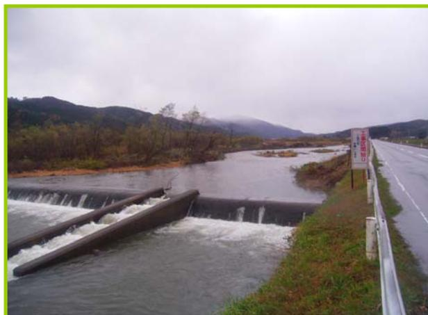
川原通地区溪流保全工事は、川の増水により洗掘された岸を護るため、現場で採取した石(大きさは35cm位)を使用して石積を行い、前面に重さ6tのブロックを422個制作して設置する工事です。
