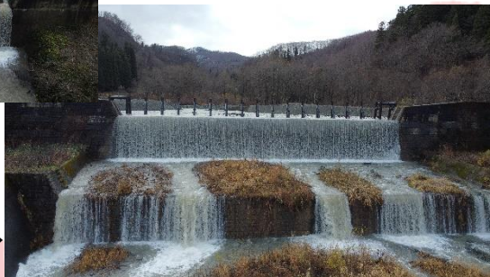
玉川第7 砂防堰堤→
