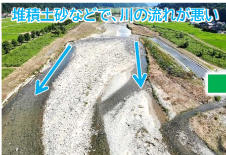
令和3年5月(着工前)
