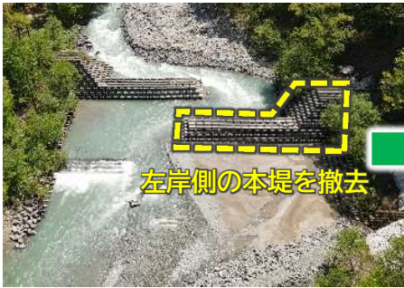
令和3年5月(着工前)
