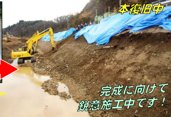
昨年度の出水による法面の損傷
