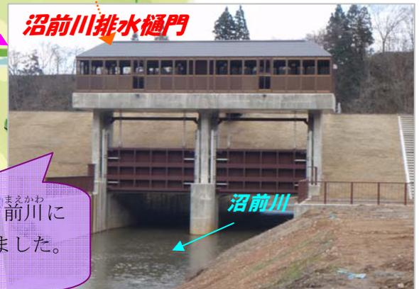
普段はゲートが開いていますが、鮭川の水位が上昇すると自動的に門が閉まり鮭川の水が川裏の水田に逆流するのを防止します！
