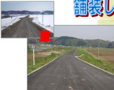
向居地区の堤防の上の舗装を行いました。舗装することで堤防上を走行しやすくなるほか、堤防に雨水が浸み込むのを防ぎ、出水時に崩れにくくなります。今年も真室川高沢橋上下流で行う予定です。
