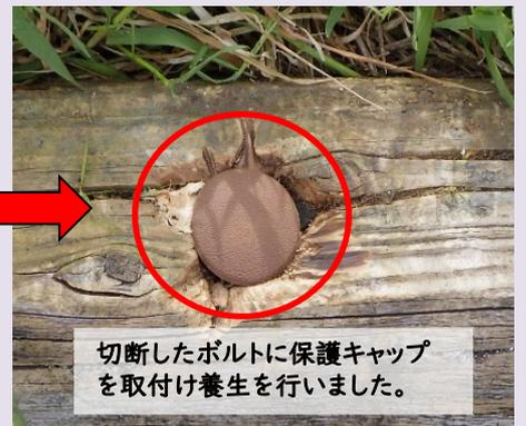
切断したボルトに保護キャップを取付け養生を行いました。
