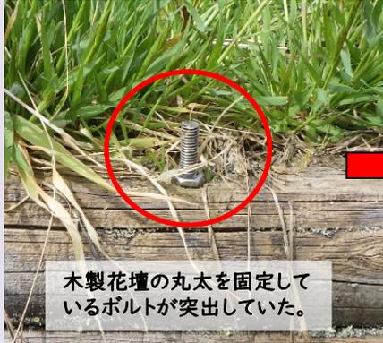
木製花壇の丸太を固定しているボルトが突出していた。
