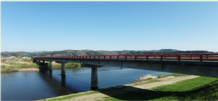
鮭川村の庭月地区にある赤い欄干が特徴の「観音寺橋」。観音寺地区と庭月地区を結ぶ橋で、長さ208.8メートル、幅6メートルの永久橋で1965年に完成しました。橋ができるまで渡し船で行き来していたそうで、完成した翌年には「橋まつり」が開かれるほど橋の完成は喜ばれたそうです。右岸には最上三十三観音の打ち止めの寺として知られる庭月観音があります。ここを流れる鮭川は大雨などで氾濫することが多かったため、国土交通省新庄河川事務所は両岸に堤防を築堤。監視カメラや水位計も設置しており、住民の安全確保に努めています。
