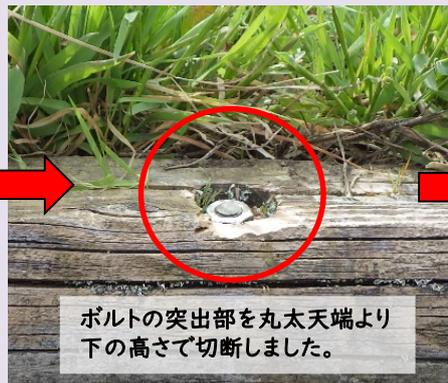
ボルトの突出部を丸太天端より下の高さで切断しました。
