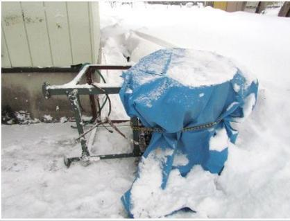
積雪や落雪の影響でタンクのレバーが動いたり、落雪によってタンクが転倒し油漏れの原因になることがあります。特に積雪の多い今の時期は、発生元の確認作業に困難が生じるためホームタンク周辺の点検や補修、除雪などお願いします。不安な場合は、業者（灯油販売店・配管設備店）に点検を依頼して下さい。
