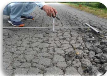
堤防天端部の亀裂が広がっていないかを確認しています
