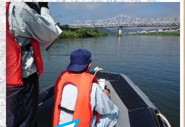
大石田大橋：橋脚に流木が集積していない状況を把握。
