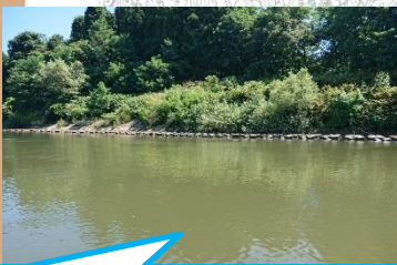
大浦地区：護岸の損傷がないか調査。
