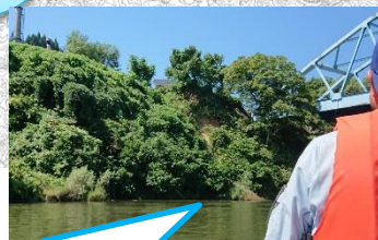
大浦橋：河岸の崩落が進行していないか目視調査。
