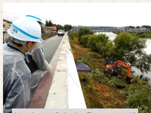
樹木伐採作業の見学
