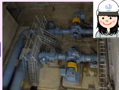
施設の中には最上川から水を取り水するポンプが2台設置され、消雪溝等に送水しています。
