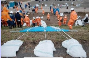
シート張り工
