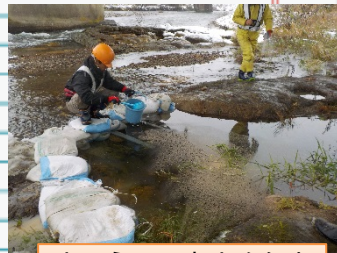
土のうでせき止めたオイルをすくって回収
