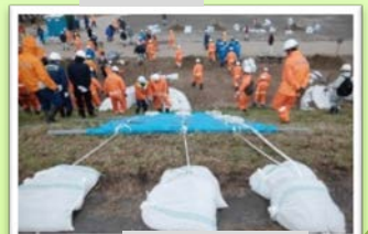
シート張り工
